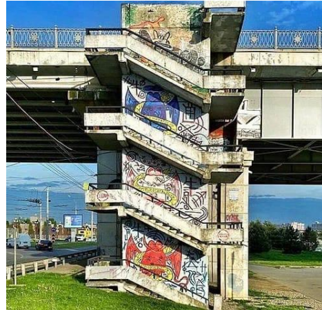
Рис 12. Опора моста в Краснодаре
