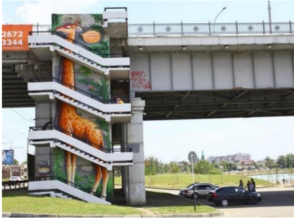
Рис 11. Опора моста в Краснодаре
