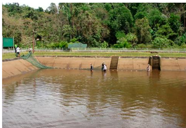
Рис. 3. Бетонный бассейн для выращивания сибирского осётра; станция Pangtong провинции Mae Hong Son, Королевство Таиланд
