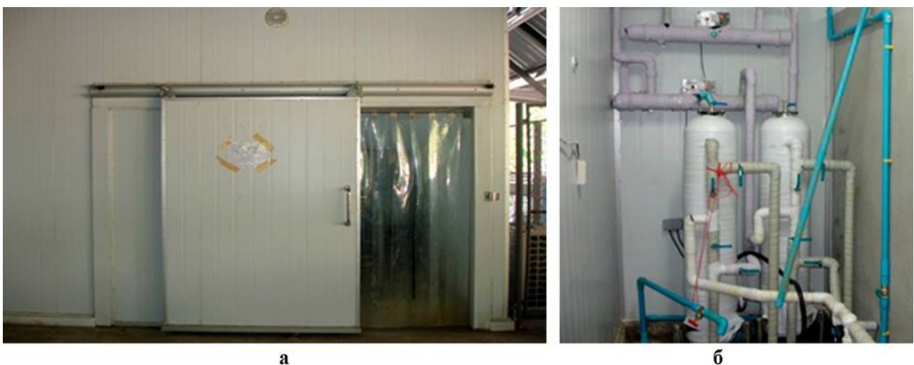
Рис. 6. Модуль искусственной зимовки ремонтно-маточного стада осётра, национальный парк DOI Inthanon, Королевство Таиланд: а — помещение для искусственной зимовки; б — система водоохлаждения
