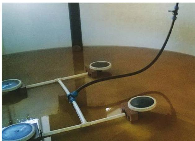
Рис. 1. Дисковые аэраторы
