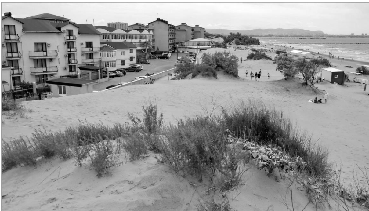
Рис. 1. Капитальное строительство в дюнном поясе
