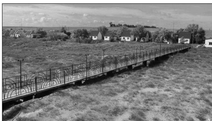
Рис. 3. Временные настилы и пешеходные мостки, улучшающие доступ на пляж; снижающие или предотвращающие повреждение дюн
