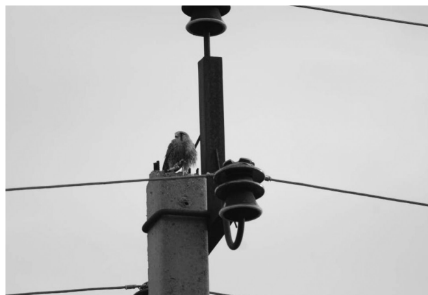
Рис. 8. Обыкновенная пустельга на птицепасной опоре ВЛ 6—10 кВ
