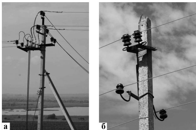
Рис. 1. Наиболее опасные для птиц воздушные линии электропередачи мощностью 6—10 кВ:
