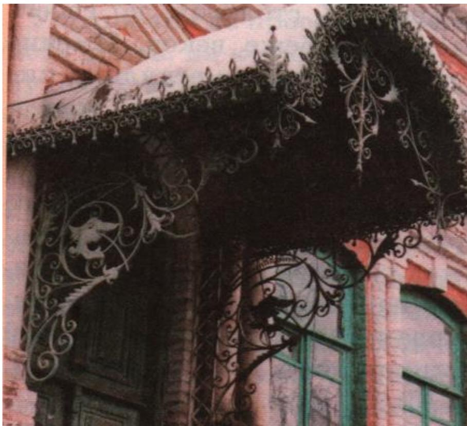
Рис. 9. Кованый навес на кронштейнах.
