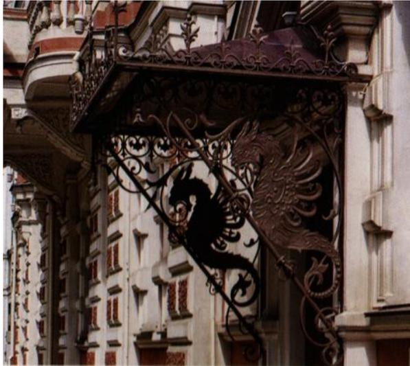
Рис. 10. Кованый навес на кронштейнах над центральным входом особняка купцов Багарсуковых, 1901 г. г. Краснодар, ул. Гимназическая, 67. Фото Ярошенко И.В. 05.08.19
