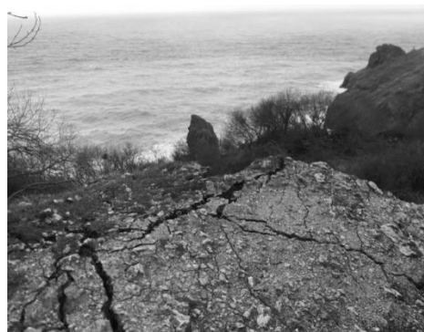
Рис. 4. Обвал грунта на м. Фиолент
