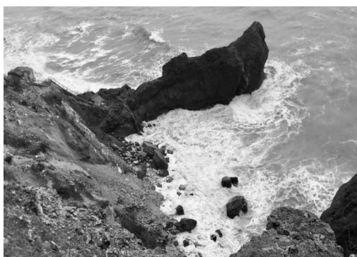
Рис. 3. Обвал грунта на м. Фиолент
