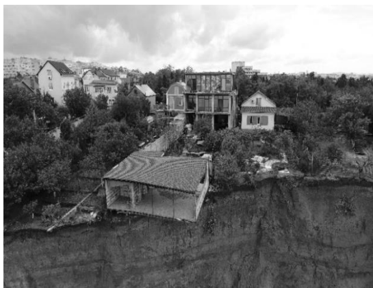
Рис. 1. Обвал грунта на территории
