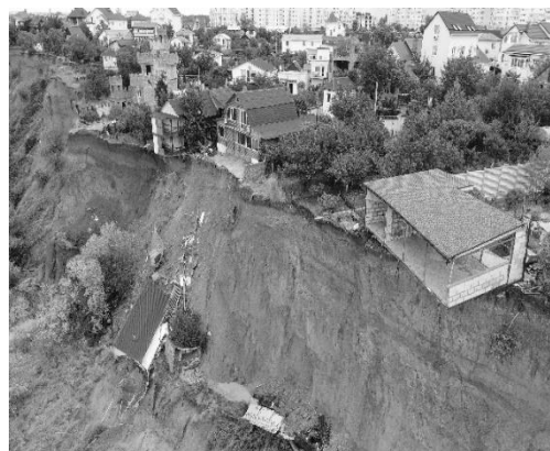
Рис. 2. Обвал грунта на территории
