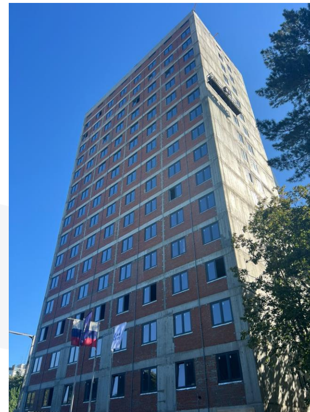
В стадии строительства два 17-ти этажных корпуса
